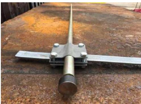
После забивки заземлителя в грунт к нему присоединяется зажим, который прижимает к заземлителю заземляющий проводник. [6]
