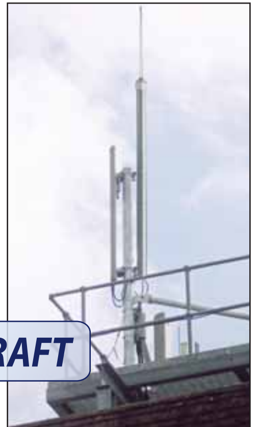
Внешний вид установленной системы с изолированным токоотводом ERITECH
