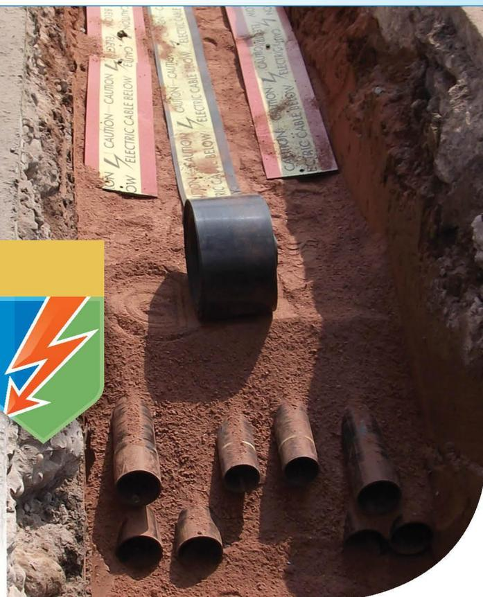
1,2 м вместо 0,9 м, прокладка волоконно-оптического кабеля.
